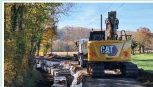
L'entreprise DSTP, installée à la zone de La Marche, a réalisé un enrochement sur la route de La Tailladié, non loin du pont de La Lande. Sur cette portion de route, l'accotement était quasi inexistant, la solution de l'enrochement a été retenue afin de créer un élargissement de voie.
